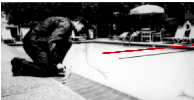
До: Безобразные трещины и утечки.
